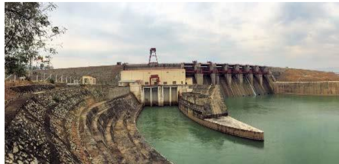
発電所放水口全景
